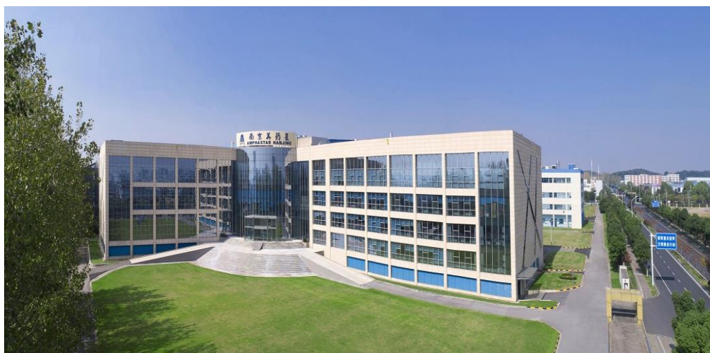
ANP 主大楼全景图
